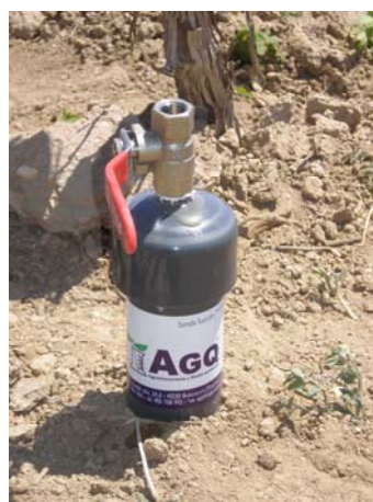
Instalación sondas de succión
